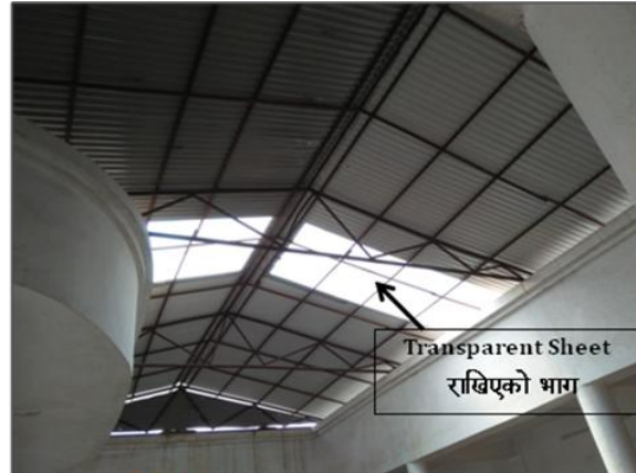
निर्माण सम्पन्न भएको छाना
