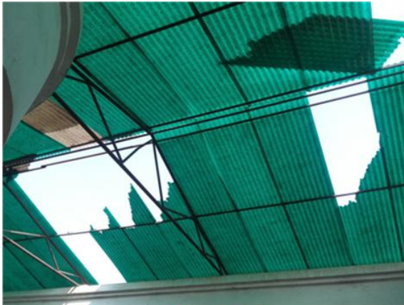
निर्माण गर्नु अगाडीको छाना
